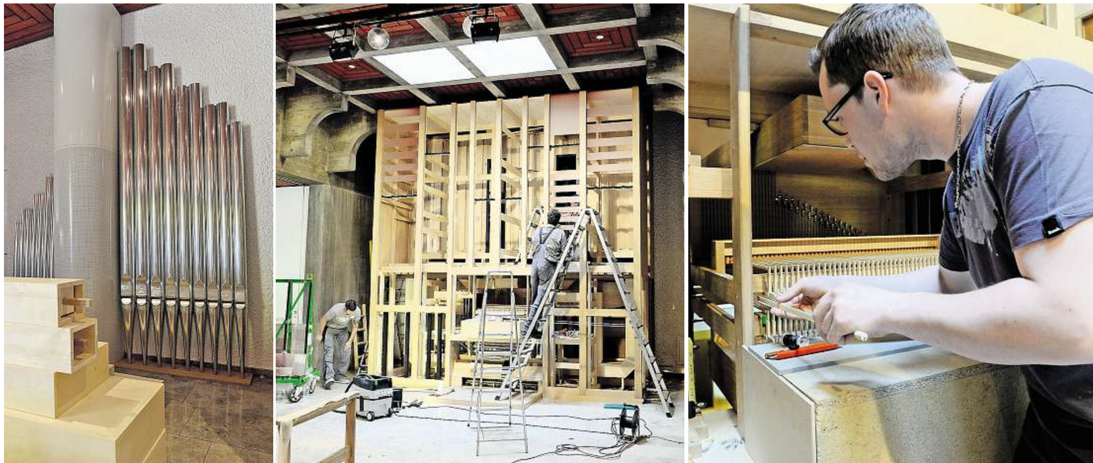
Die Lücke gefüllt: Nach über 40 Jahren wird die Orgelnische in der Kirche St. Urban mit einem massgefertigten Instrument bestückt. Die Kassettendecke des Raums (mittleres Bild, oben) stellt ein akustisches Problem dar. Heinz Diener
