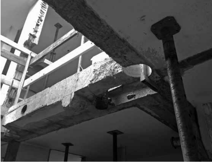
Ein massiver Eingriff ist der Einbau des Lifts. Diese Ansicht zeigt die Situation vom EG zum ersten OG.
