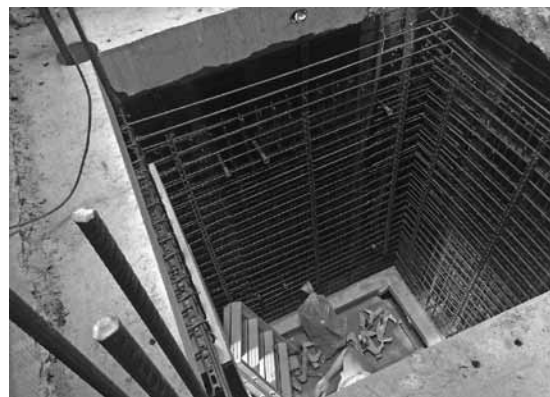
Der Liftschacht von oben. Bereits sind die Armierungseisen gelegt.
