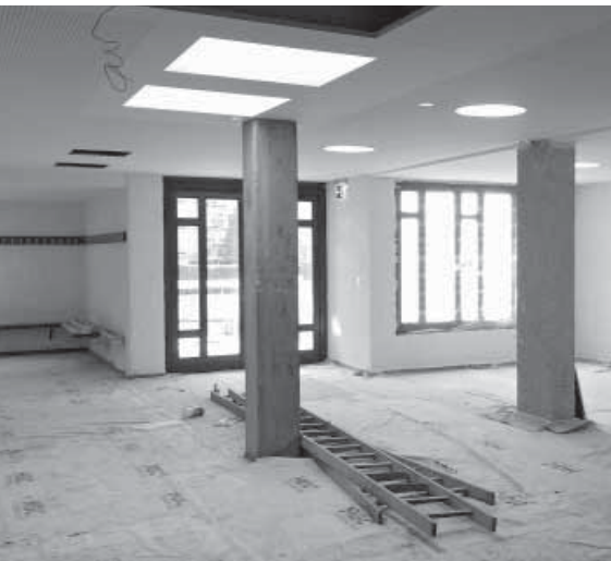
Das neue vergrösserte Foyer.
